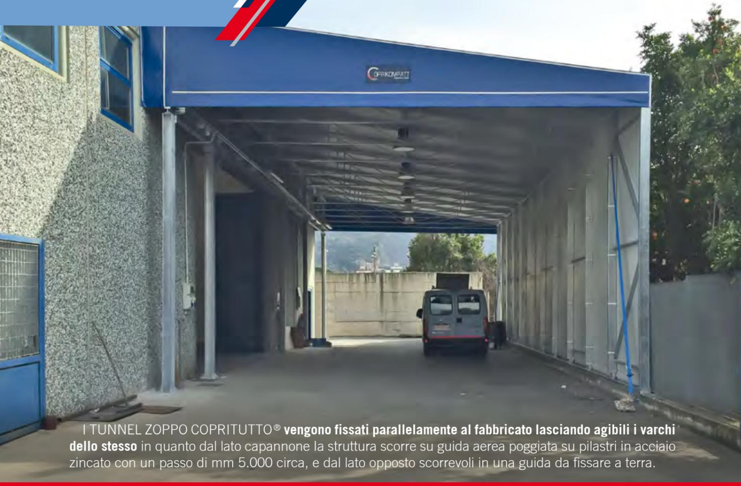
I TUNNEL ZOPPO COPRITUTTO® vengono fissati parallelamente al fabbricato lasciando agibili i varchi dello stesso in quanto dal lato capannone la struttura scorre su guida aerea poggata su pilastri in acciaio zincato con un passo di mm 5.000 circa, e dal lato opposto scorrevoli in una guida da fissare a terra.
